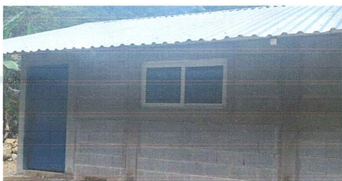
Foto 3: Mejoramiento de la estructura del techo de la EORM Caserío Concepción las Flores
