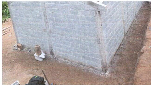
Foto 2: Mejoramiento de paredes a muros de block de la EORM Caserío Concepción las Flores
